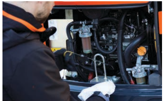
Die Wartungspunkte für die Tagesinspektionen wurden in bequem zugänglichen Gruppen angeordnet.
